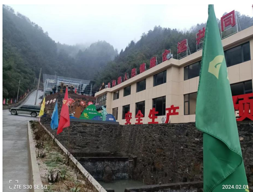
老矿区—矿区公路升级改造工作
